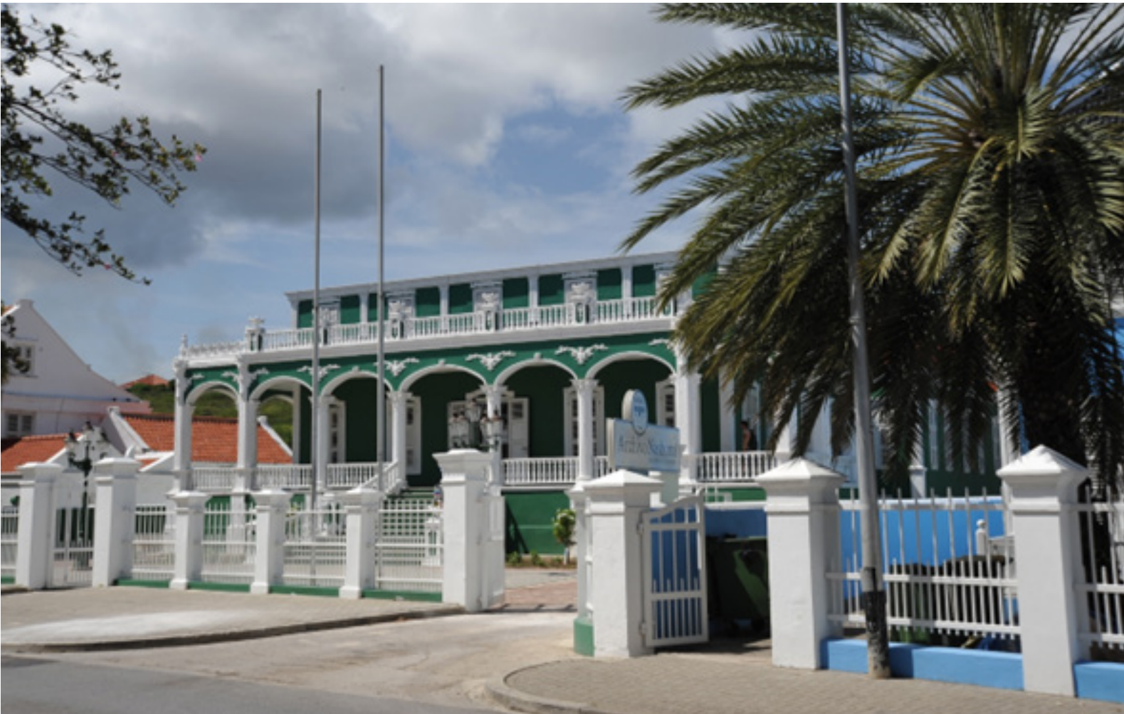
Edificio sede principal del Archivo Nacional de Curazao
