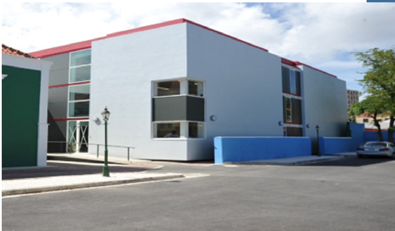
El nuevo y moderno depósito de archivos, terminado en 2011
