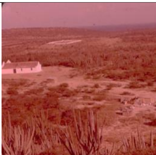
El valle de El Carrizal en la década de los 60. Foto: José María Cruxent. Se observa el mal estado del techo de la iglesia y la torre conserva su cupulín.
