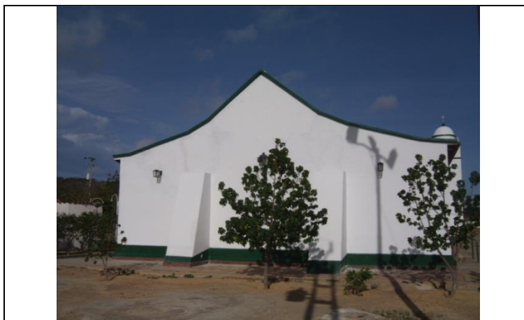
Parte posterior del templo donde estuvo la sacristía. Ahora la pared lo sostienen dos contrafuertes. Foto: Nohé G. Gilson R.
